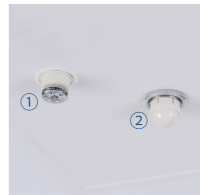
① 感知部および② 放射ノズル 見えるのほんの一部ですが、確実に見守っています。感知部が72℃の熱を感知すると、放射ノズルから消火薬剤を放出します。
